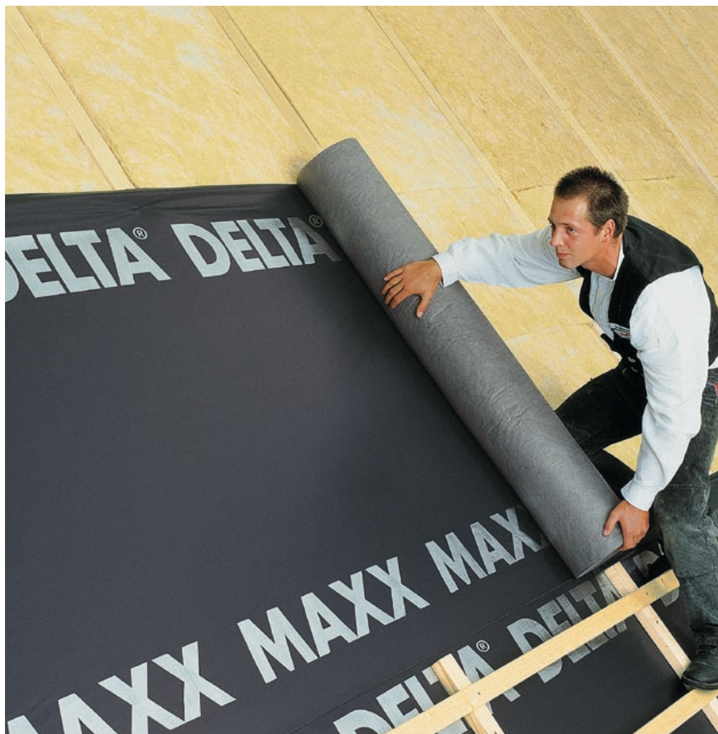
DELTA®-MAXX - najczęściej sprzedawana w Niemczech folia wstępnego krycia do dachów skośnych.
